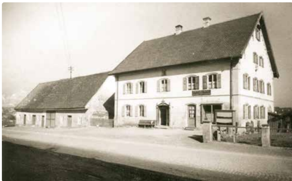
Die Bäckerei Seitz um 1948. Das 1874 erbaute Haus wurde 1965 von der Baufirma Brunetti umgebaut. Foto Elisabeth Seitz.
